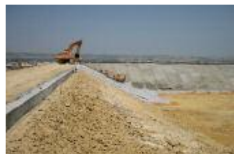
Travaux de construction du réservoir principal
