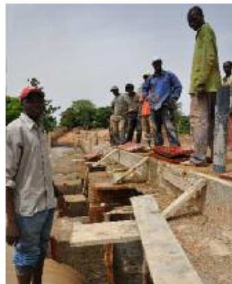
Travaux de construction du pont-barrage dans la région de Bélédougou
