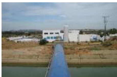
Vue de la station de pompage principale
