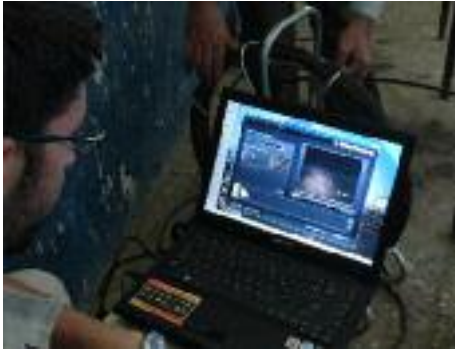
Inspection non destructive d'une conduite d'aspiration par caméra vidéo
