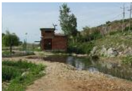
L'ancienne station de pompage sera démolie et reconstruite
